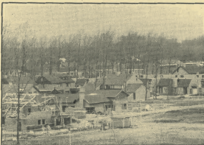
● Koudenhoven in aanbouw.
